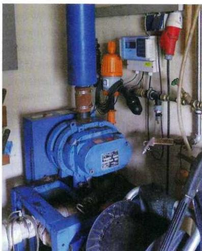
Nachrüsten der bestehenden Vakuumpumpe auf Frequenzsteuerung.
