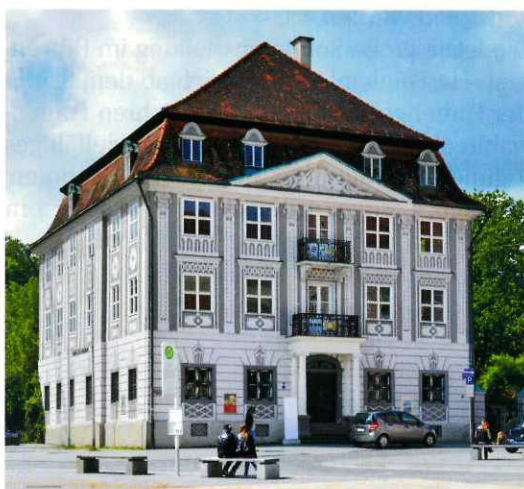
Das Zumsteinhaus vor dem Umbau
