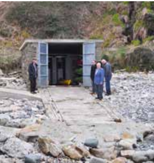
▲ Renovierter Bootsschuppen für Kajaks in Fort Dunree.
