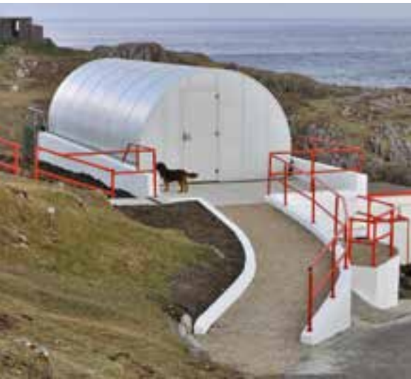
▲ Das neue Informationszentrum am Leuchtturm Fanad.
