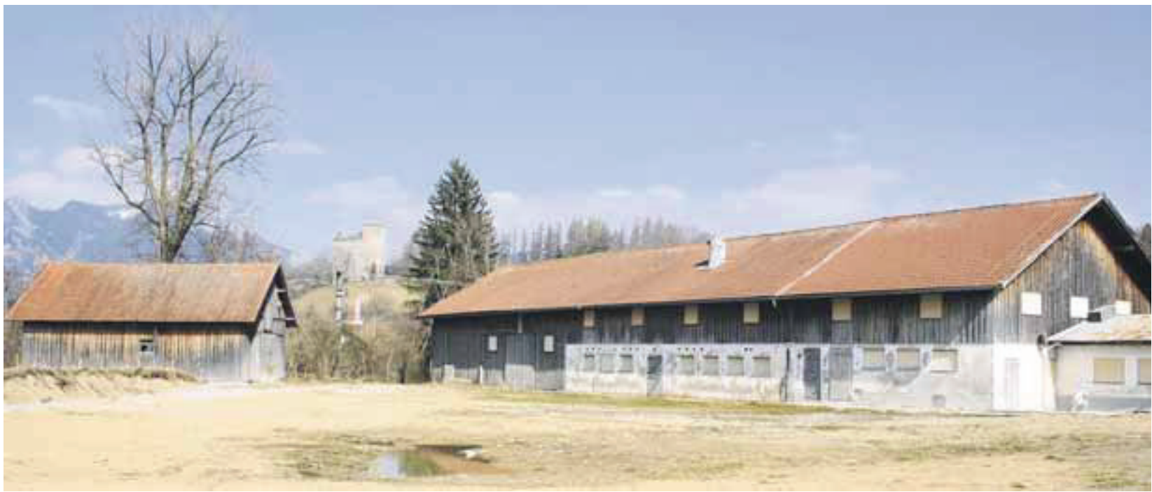
Stadtnah gelegen ist der frühere Schneiderhof ein attraktiver Standort für ein Naturerlebnisprojekt. Das ehemalige Wohngebäude, Laufstall, Güllegrube und Fahrsilo sind bereits abgerissen.
