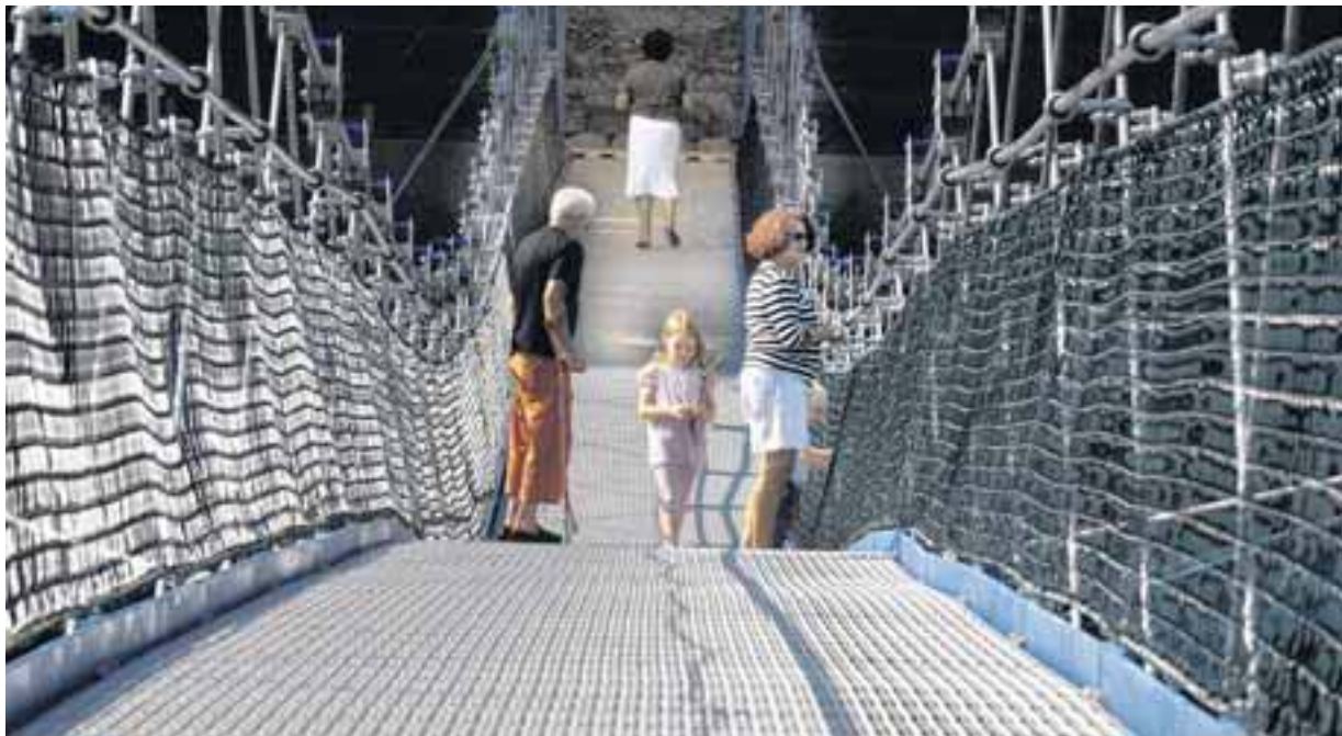
Seit zwei Jahren Besuchermagnet: Die Hängebrücke, die Pfosn (Dietmannsried) mit Fischers (Altusried) verbindet. Foto: Ernst
