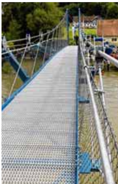
Eines der Leader-Projekte: die Hängebrücke bei Altusried, die 2009 eingeweiht wurde. Archivfoto: Ernst
