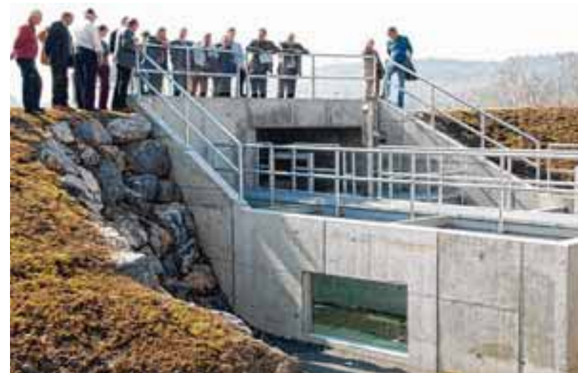
Die Fischtreppen am Unterallgäuer Iller-Verlauf werden jeweils mit einer Fischbeobachtungsstation ausgerüstet. Damit soll untersucht werden, wann welche und wie viele Tiere den Weg über die Fischtreppe ins Oberwasser finden. Unser Bild entstand bei Lautrach, wo bereits das Schaufenster (unten Mitte) zum Beobachten der Fischwanderung zu sehen ist.
