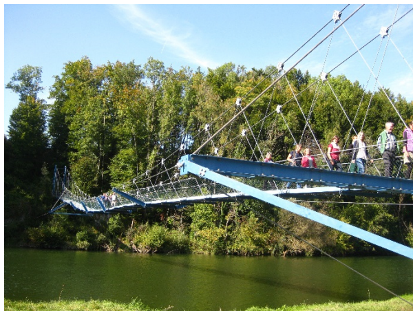
Als erstes LEADER-Projekt an der Iller war im Jahr 2007 die Hängebrücke zwischen Fischers
